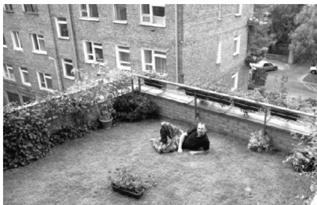
Zdjęcie 4. Zieleń na dachu
