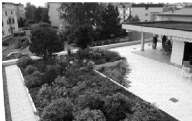
Zdjęcie 3. Zielen wykonana na dachu budynku
